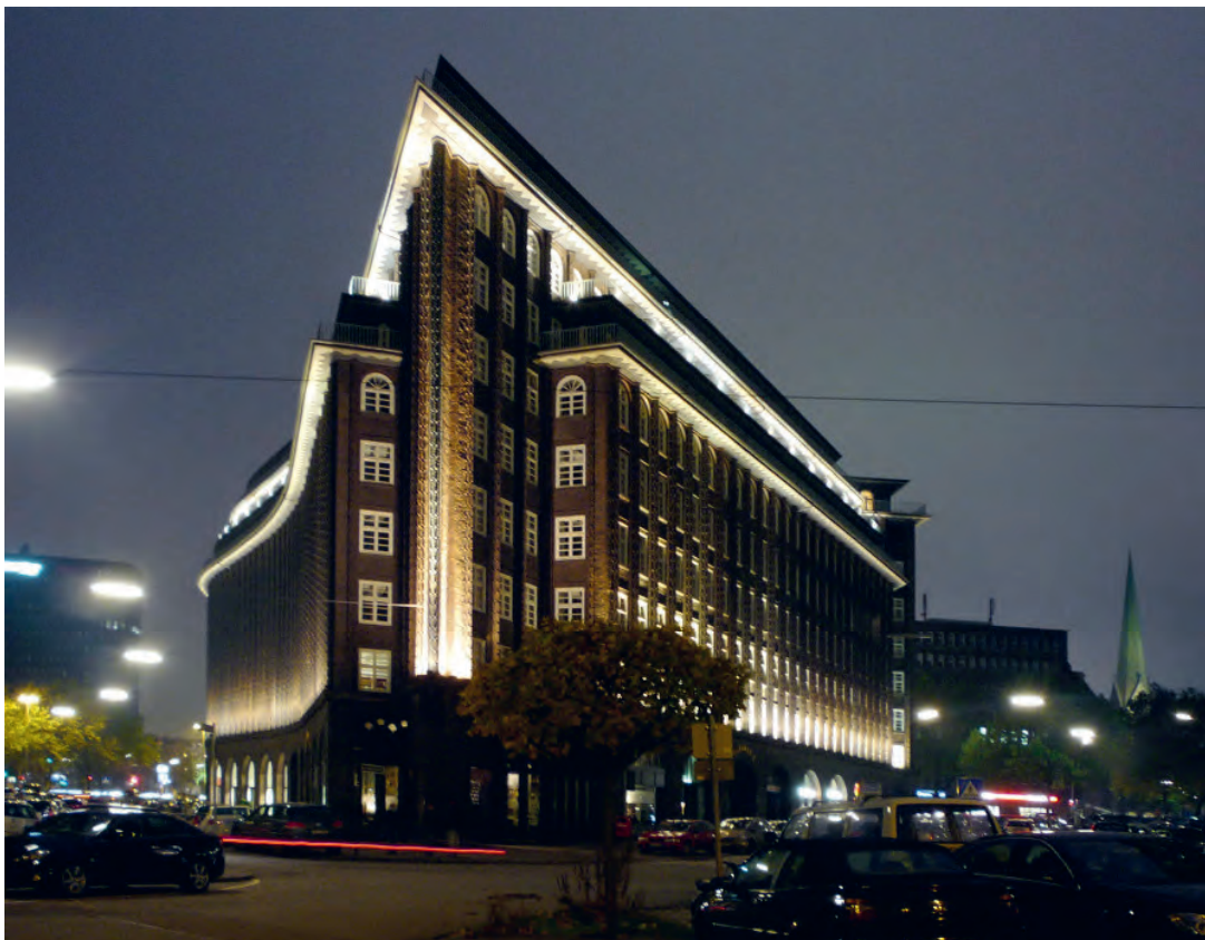
Fritz Höger: Chilehaus in Hamburg, 1924
