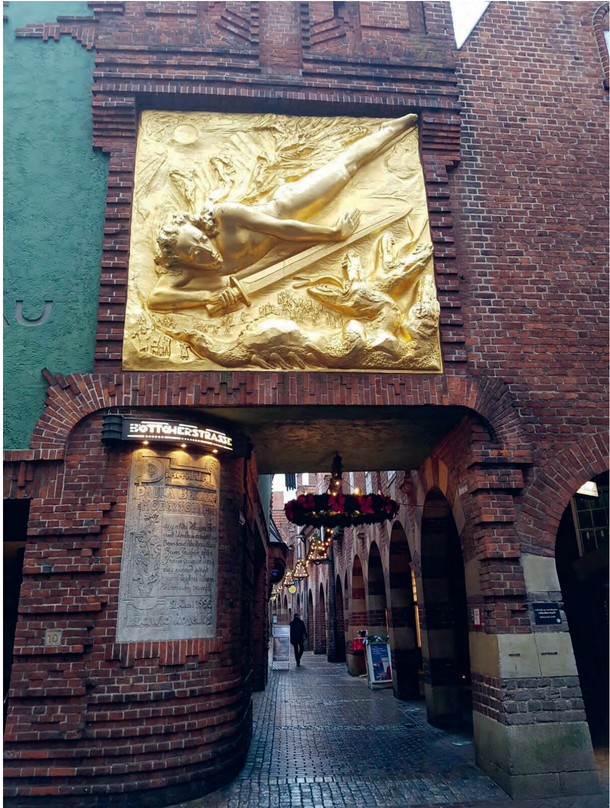
Eingang zur Böttcherstrasse in Bremen, 1922-1931
